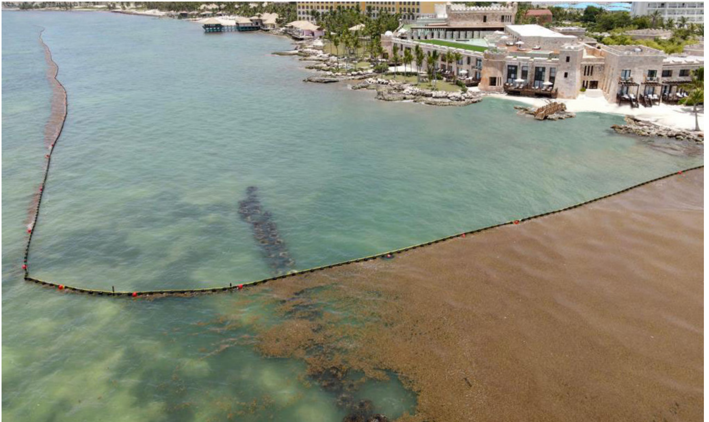
Barrière Mursargaz P1000 avec filet, retenant les sargasses à proximité d'une plage.
